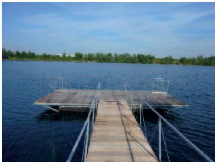
Gravière du fort de Holtzheim : Des pontons ont été installés afin de faciliter l'accès des plongeurs au point d'eau.
